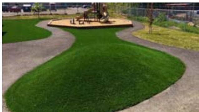
Surface en gazon synthétique pour la butte et la surface du module de jeux existant
