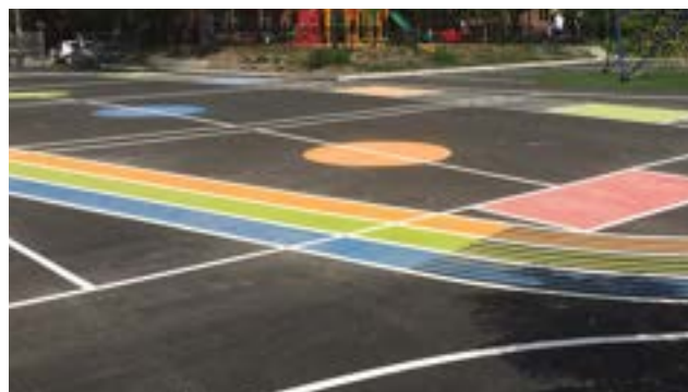
Surface en asphalté avec marquage au sol pour la cour d'école et pour le stationnement
